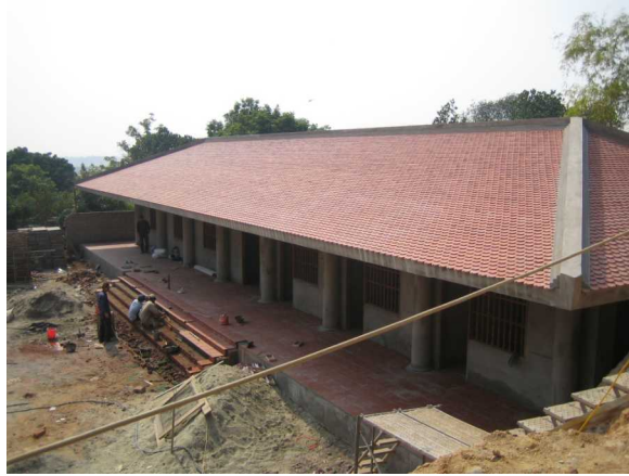
建設中のセンター
